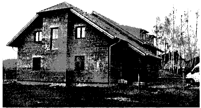
In Priesern wird ein Feuerwehrhaus gebaut.
